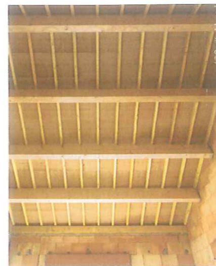
Vue intérieure de la maison. La solution adoptée en toiture maximise les surfaces et préserve totalement les pannes apparentes.
