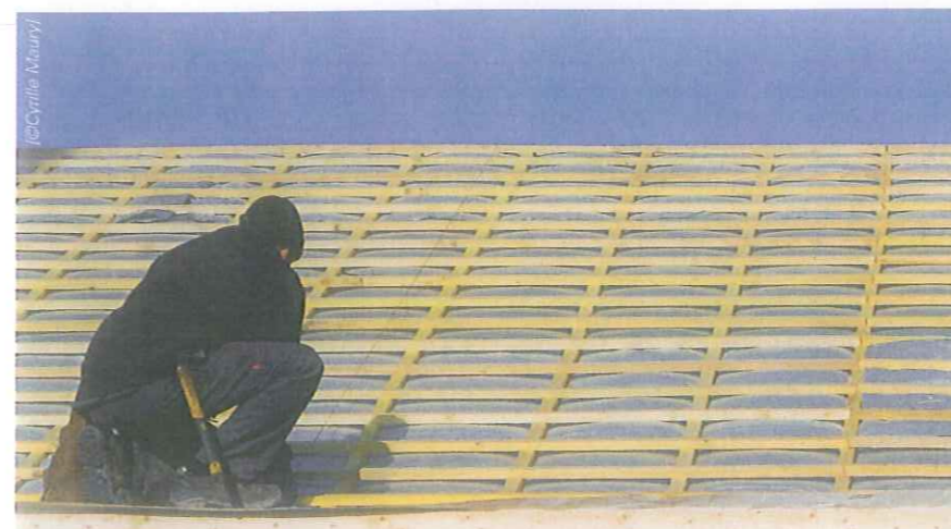
Fin de la pose des liteaux : 2 jours de travail ont été nécessaires pour isoler et pré-tuiler les 80 m 2 de la toiture à doubles pans.
