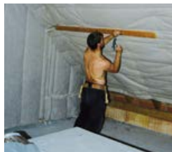
Pour assurer une parfaite fixation à la jonction des lés, fixer une lame de bois clouée ou vissée sous chevron.
