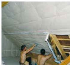
Assurer un recouvrement des lés de 5 cm.
