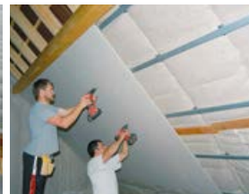
Poser la finition plaque de plâtre.
