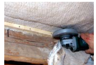
TechTOIT se découpe facilement à la meuleuse, équipée d'un disque fin.
