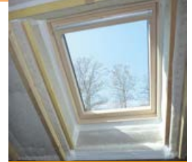
Parfaite isolation et étanchéité à l'air autour des fenêtres de toit
