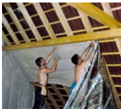
Couper au sol les lés. Agrafier sous chevrons, entre pannes.
