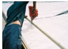
Contre-latter dans le sens de la pente. Pose par vis, pointes crantées ou torsadées
