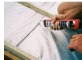
Mettre un cordon de colle P.U. pour l'étanchéité
